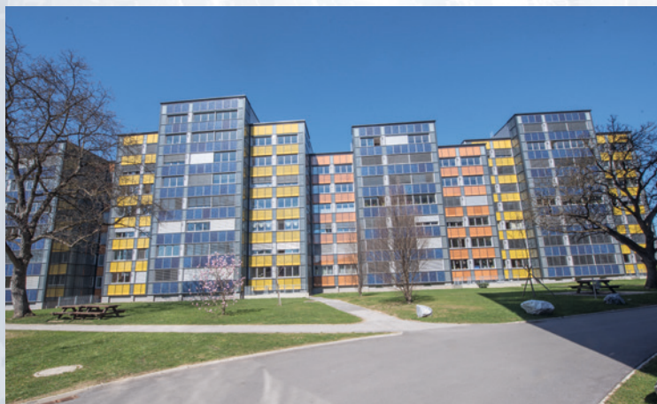
Energetische Sanierung in großem Stil: Projekt Liebenauer Hauptstraße in Graz
